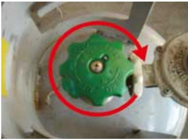
19 消火したことを確認して、プロパンガスの元栓を完全に閉めます。
